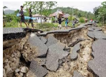
Gambar 2. Kerusakan Lingkungan Akibat Gempa Bumi (Sumber: http://www.beritadaerah.com )
